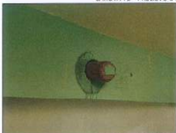
CAROTA T2 – PRELIEVO E PROVA DI CARBONATAZIONE
