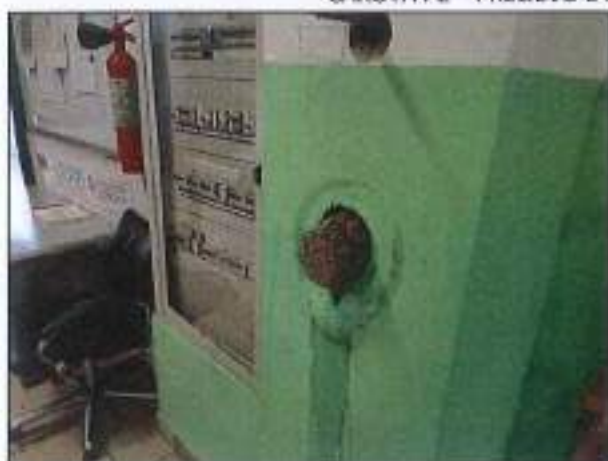
CAROTA P3 – PRELIEVO E PROVA DI CARBONATAZIONE
