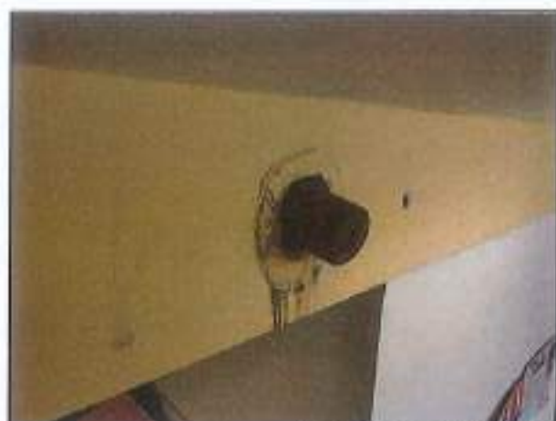
CAROTA T10 – PRELIEVO E PROVA DI CARBONATAZIONE
