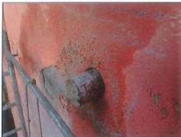
CAROTA T7 – PRELIEVO E PROVA DI CARBONATAZIONE
