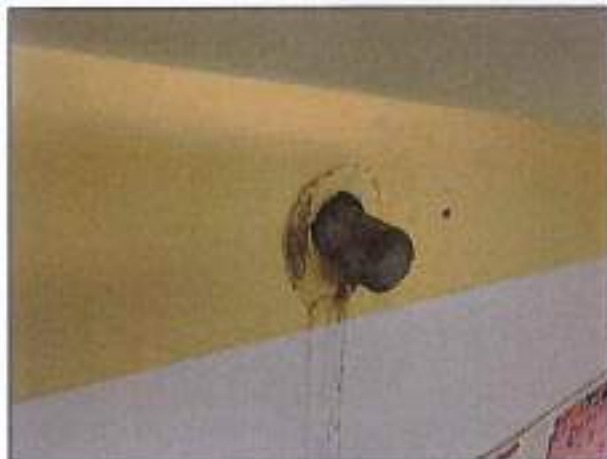
CAROTA T9 – PRELIEVO E PROVA DI CARBONATAZIONE
