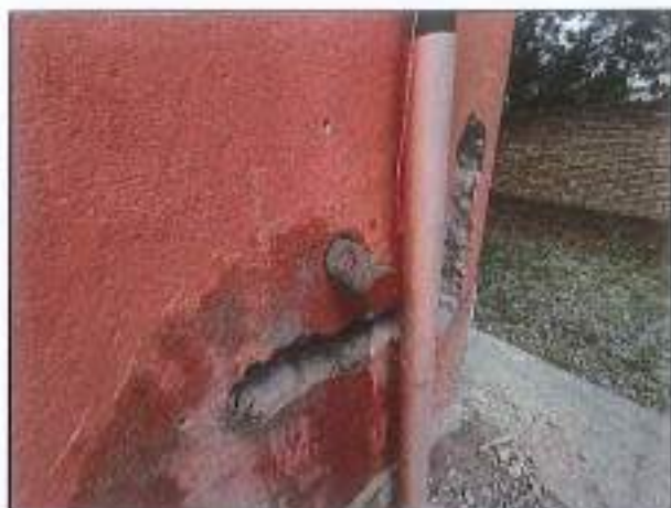
CAROTA P4 – PRELIEVO E PROVA DI CARBONATAZIONE
