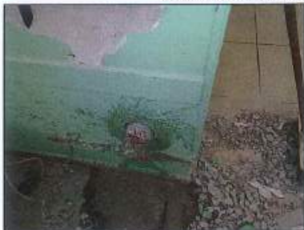
CAROTA P5 – PRELIEVO E PROVA DI CARBONATAZIONE
