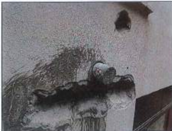
CAROTA T5 – PRELIEVO E PROVA DI CARBONATAZIONE
