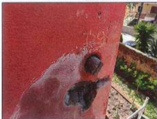
CAROTA P9 – PRELIEVO E PROVA DI CARBONATAZIONE
