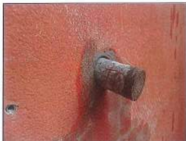
CAROTA T1 – PRELIEVO E PROVA DI CARBONATAZIONE
