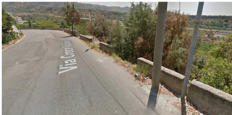
Figura 3 - Via Croce Valanidi: ostacoli interni alla carreggiata; assenza di barriere di protezione laterale, assenza di opere di regimazione idraulica
