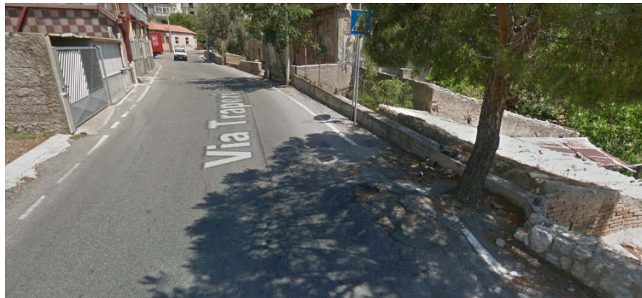
Figura 2 - Via Trapezi: ostacoli interni alla carreggiata; sagoma pericolosamente deformata, assenza di opere di regimazione idraulica
