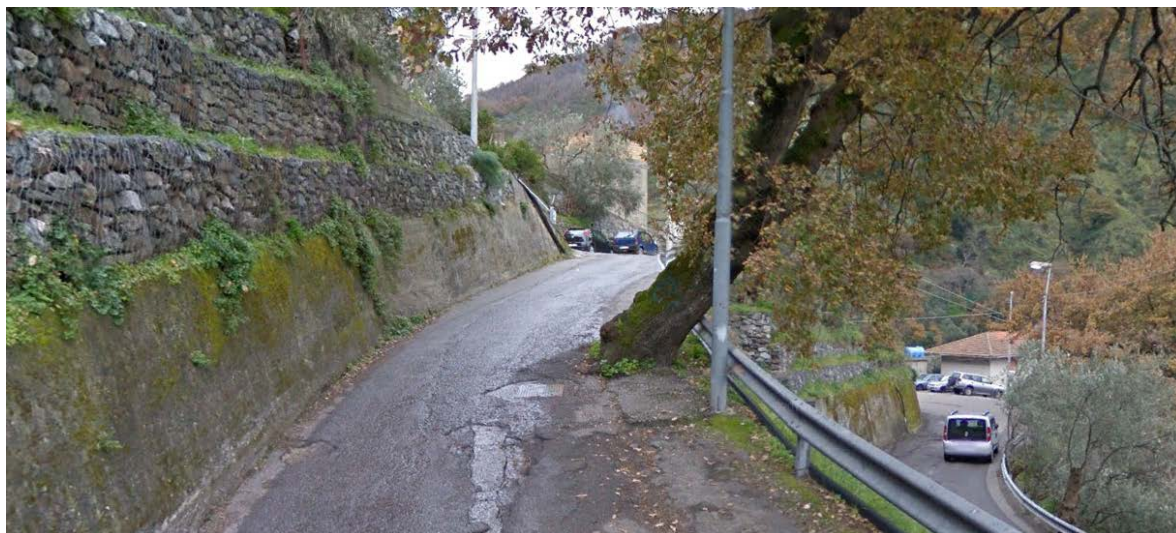
Figura 10 – SP Trunca – Loc. Paviglianiti: ostacoli interni alla carreggiata; sagoma deformata; barriere laterali inadeguate
