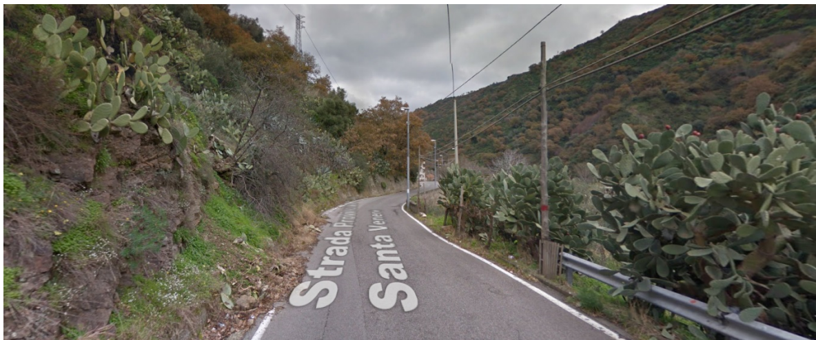
Figura 9 - c.da Allai - Bivio Santa Venere - Dilavamento delle scarpate ed assenza di barriere laterali
