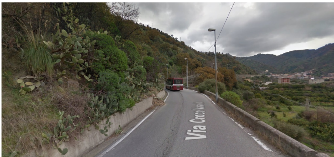
Figura 7 - Candico - via Casale - Dilavamento delle scarpate e parapetti bassi
