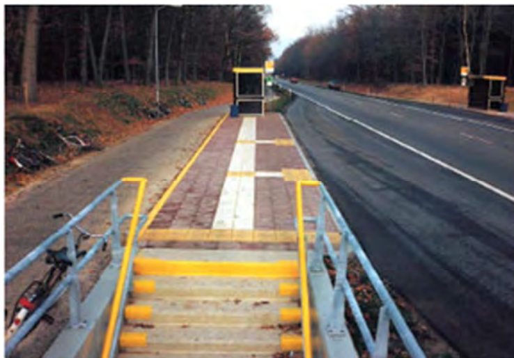
Figura 6.31 Esempio di pavimentazione di orientamento per non vedenti per accesso alla fermata del TPL
