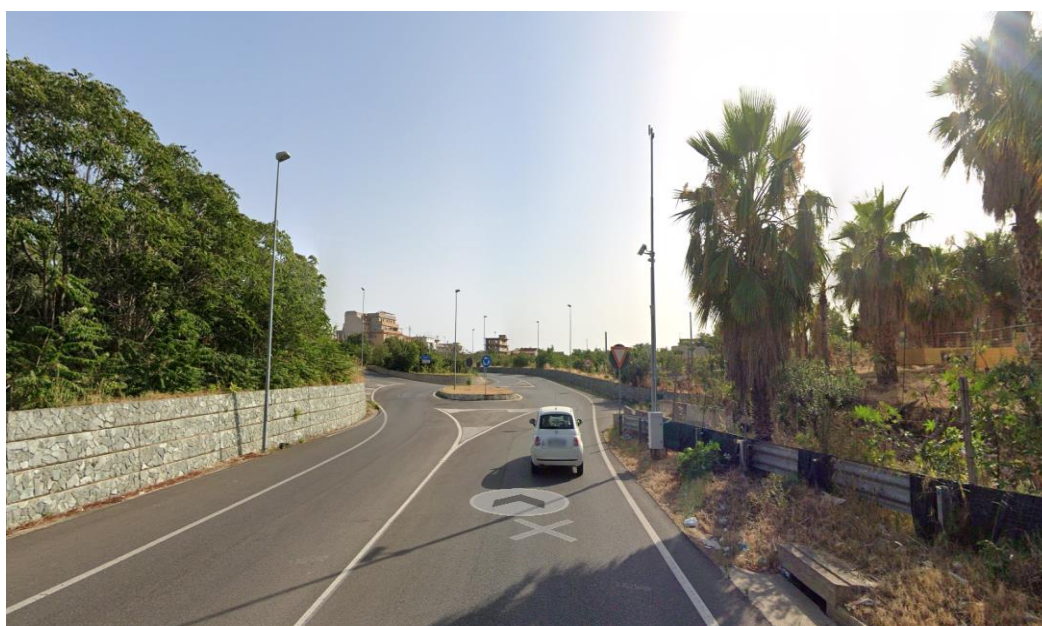
Foto 6 – Vista della viabilità di svincolo esistente e dell'isola stradale che sarà sostituita dalla seconda rotatoria
