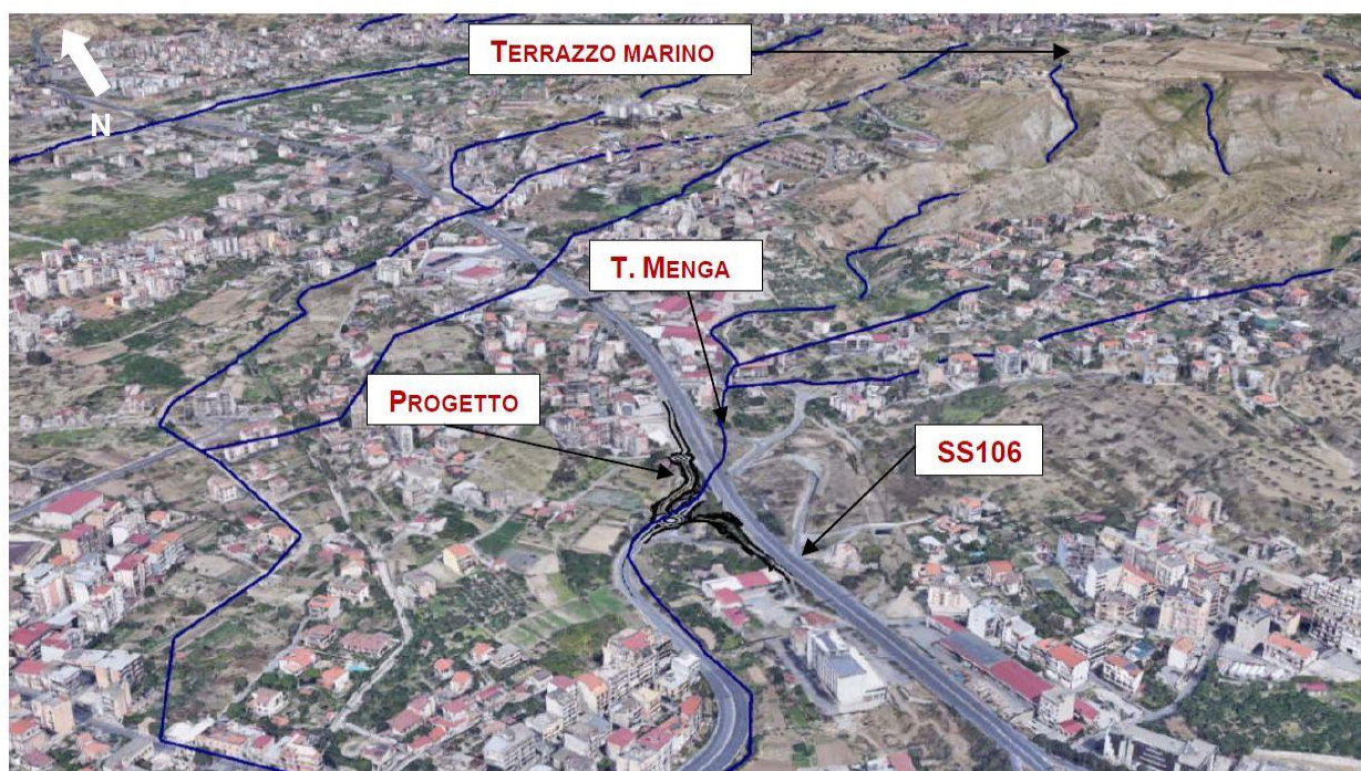
Fig. 14 – Panoramica area intervento con indicazione idrografia interferente
