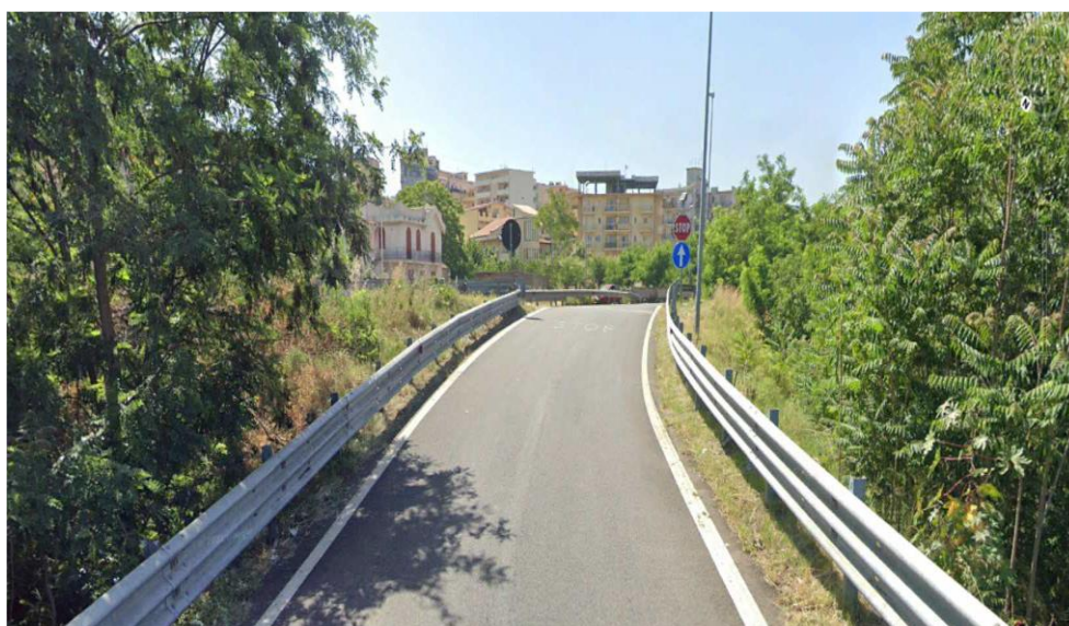
Fig. 10 – Rampa esistente di immissione in direzione Taranto
