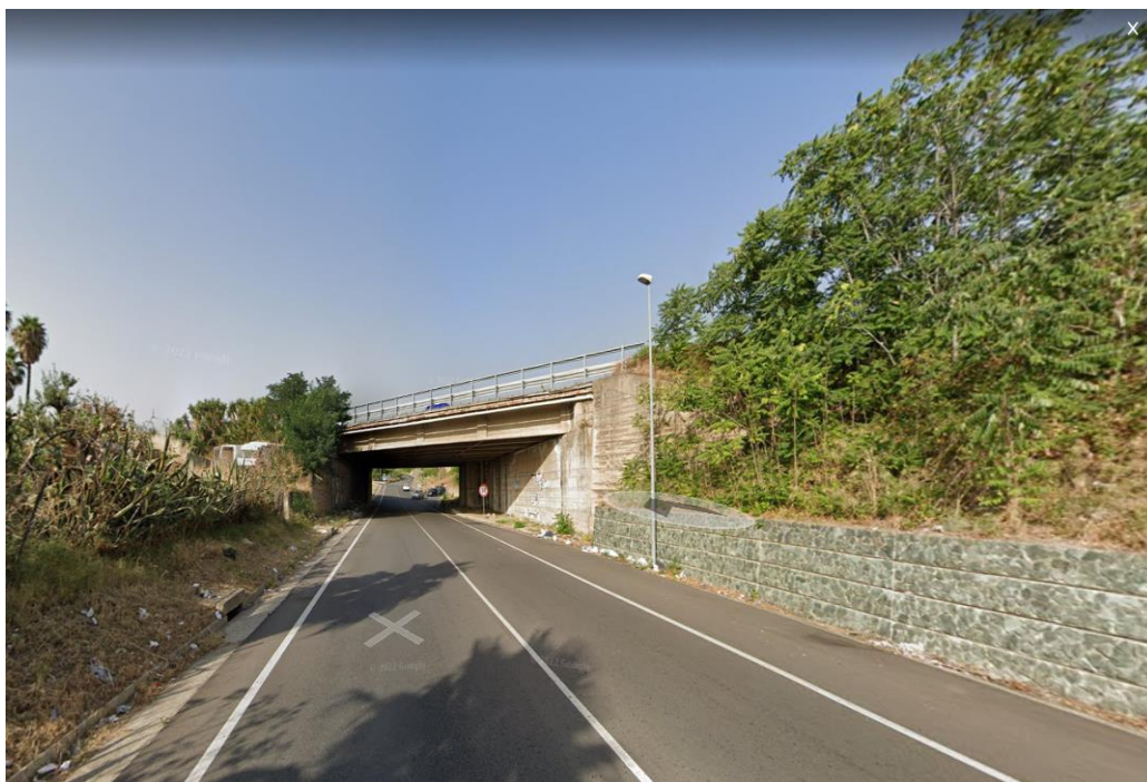
Foto 5 – Vista della viabilità di svincolo esistente e del cavalcavia della SS106
